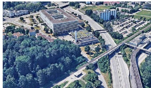
Der Bahnhof Kloten-Balsberg mit dem kleinen Hauschen (vorne unten) wird bis 2026 doppelspurig und soll mit neuen Zugangen auch das Priora-Entwicklungsgebiet nenn der Autobahn (Parkplatz und Wiesen rechts oben) erschliessen. Screenshot: Google
