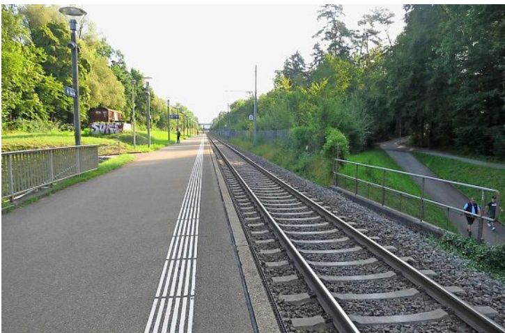
Das von den SBB als «überlang» bezeichnete Perron am Balsberg erhält im Zuge des Doppelspurausbaus eine neue Fussgängerunterführung und breitere Zugangswege auf beiden Seiten. Foto: Wild Ingenieure/SBB
