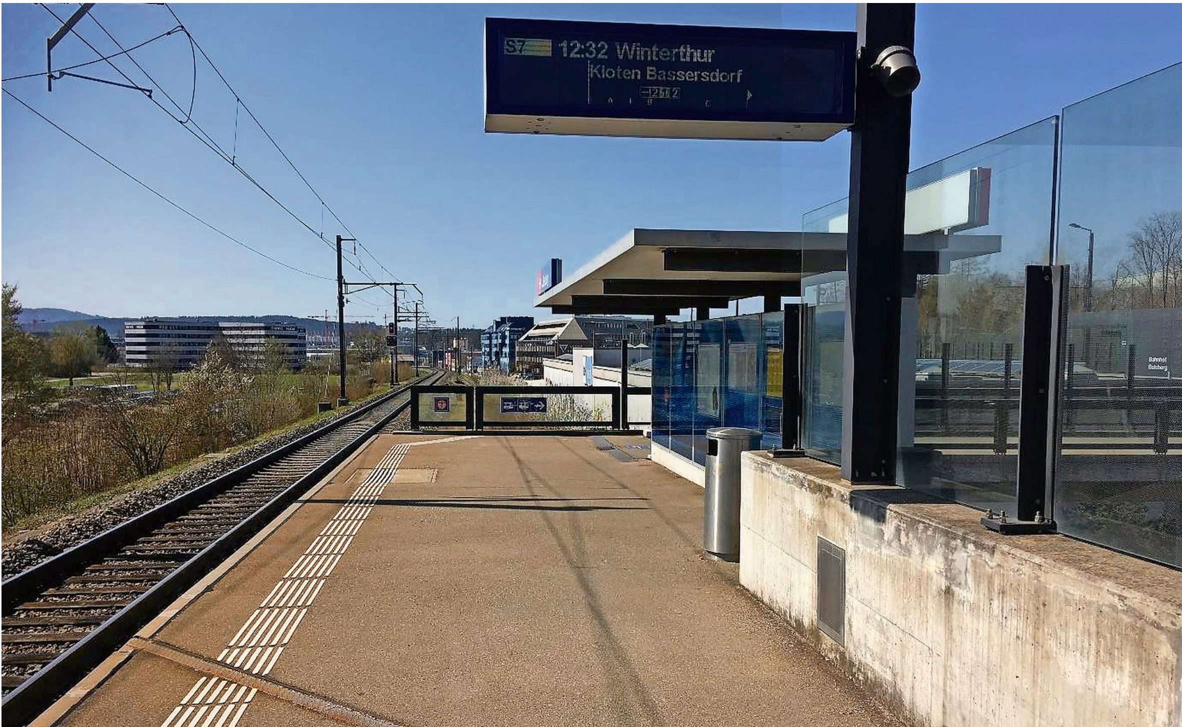
Blick vom Perronende am Balsberg in Richtung Glattbrugg. Hier wird auf der linken Seite ein zweites Gleis samt Perron gebaut. Foto: SBB
