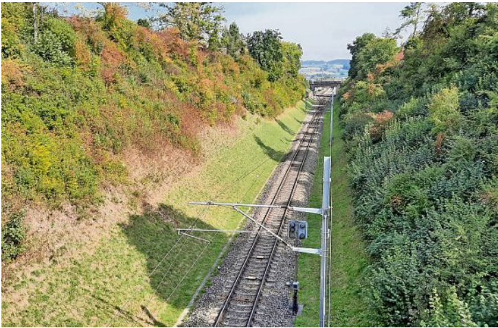
Im Geländeeinschnitt zwischen den Stationen Balsberg und Kloten (hinten) liegt seit jeher nur ein Gleis. Foto: Christian Wüthrich
