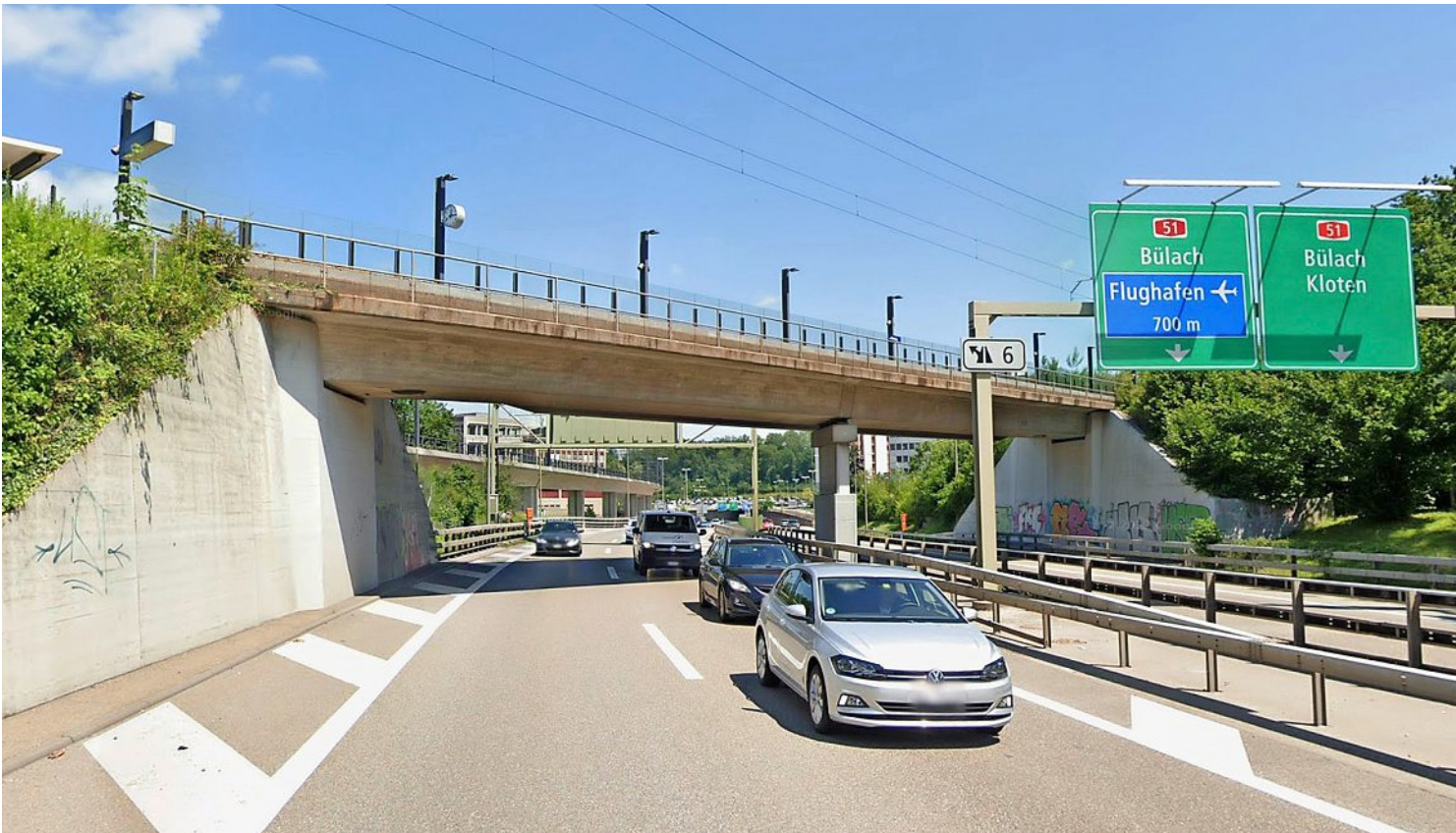
Die heute nur einspurige Bahnbrücke über die A51 an der Haltestelle Balsberg muss für den Ausbau komplett neu gebaut werden. Foto: Google Streetview
