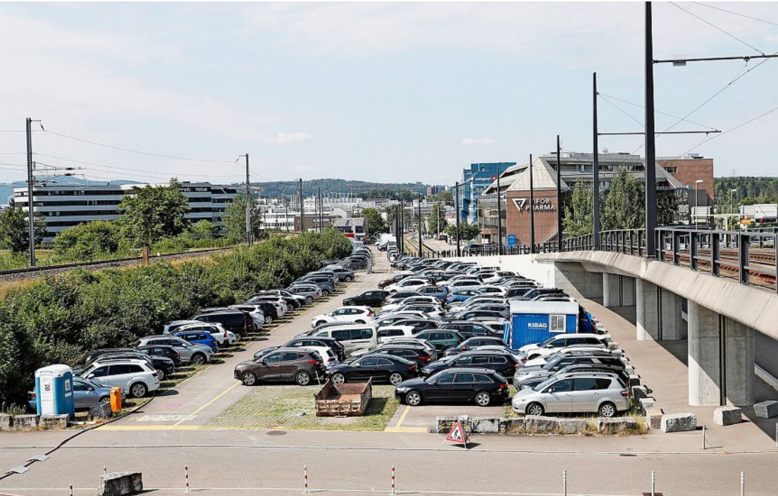
Der Blick zwischen den Gleisen in Richtung Opfikon zeigt den langen, immer schmaler werdenden Parkplatz, wo nun ein weiteres Hotel hinkommen soll. Im Hintergrund das 2014 eröffnete Dorint Hotel. Foto: Sibylle Meier
