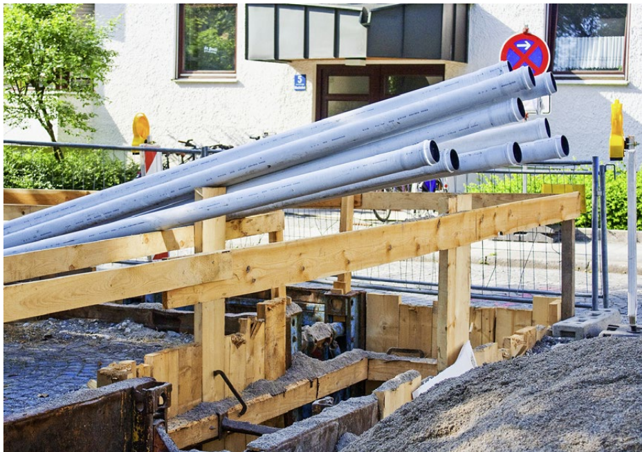
Rohrleitungen für Fernwärme warten auf ihren Einbau: Die Stadt Zürich will bis 2040 ihrerseits rund 150 000 Haushalte ans Fernwärmenetz anschliessen und ist bereit, hierfür 1,5 Milliarden Franken auszugeben.
