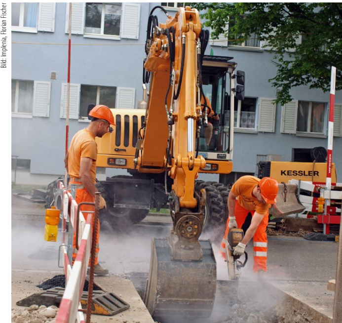
Erstellen eines Schachts für den Bau von Fernwärme- und Kälteleitungen: Für den Verbund Airport City sollen die Bauarbeiten Anfang 2024 erfolgen, damit bereits im nächsten Winter erste Kunden versorgt werden können.
