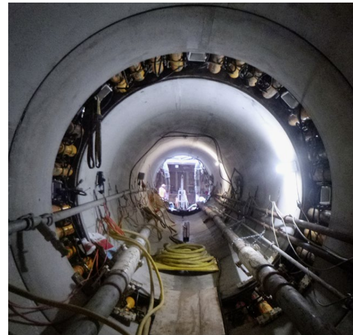
Bau einer Verbindungsleitung für den Bereich Fernwärme Zürich West: Mittels Tunnelbohrmaschinen und anderer grabenloser Methoden soll die Beeinträchtigung an der Oberfläche auf einem Minimum gehalten werden.
